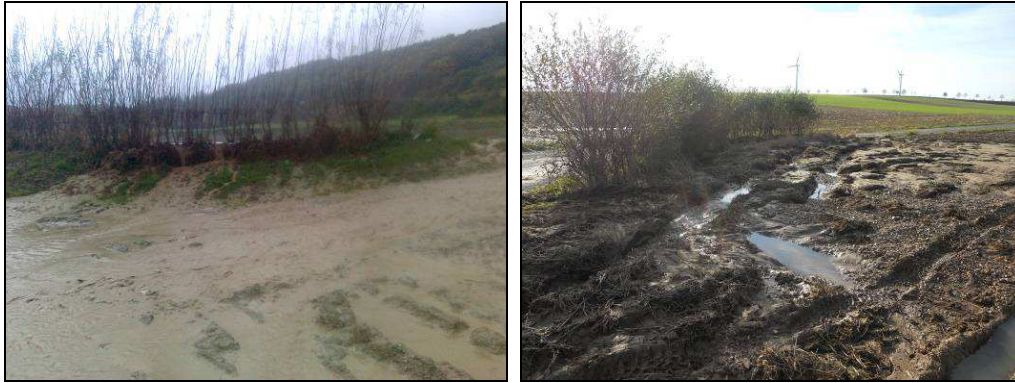
Fascines ayant joué leur rôle, mais ayant été endommagées face à des flux trop importants.
