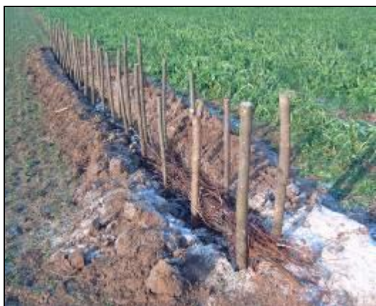
Préparation de la tranchée
