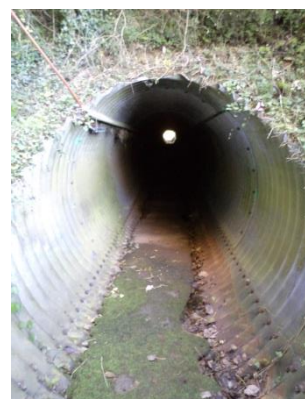
Buse \Phi 2000\text{mm} sous la RD901, amont de la Dordonne
