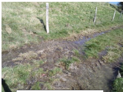
Infiltration d'eau à travers la digue
