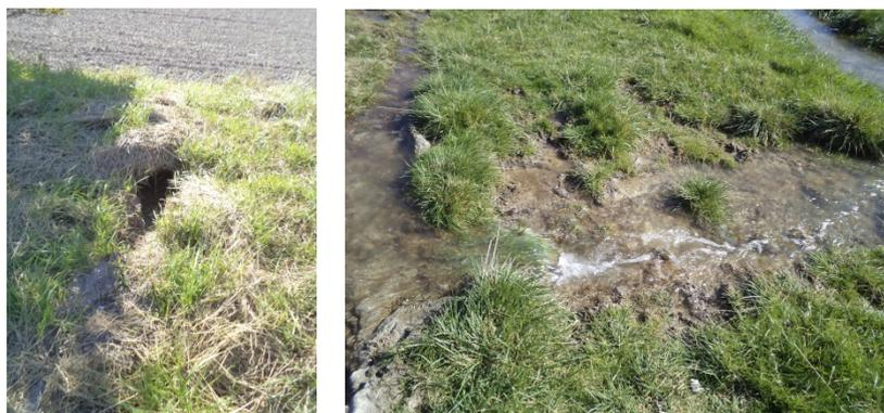
Figure 3-16 : Photographie d'un terrier (à gauche) et d'infiltrations (à droite) dans la digue « Nempont » - hydratec
