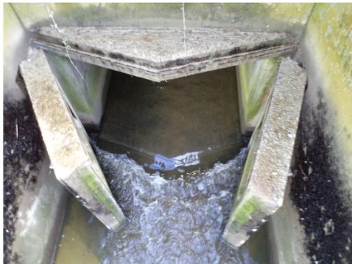
Figure 3-12 : Photographie de la porte à marée de l'A16 - hydratec
