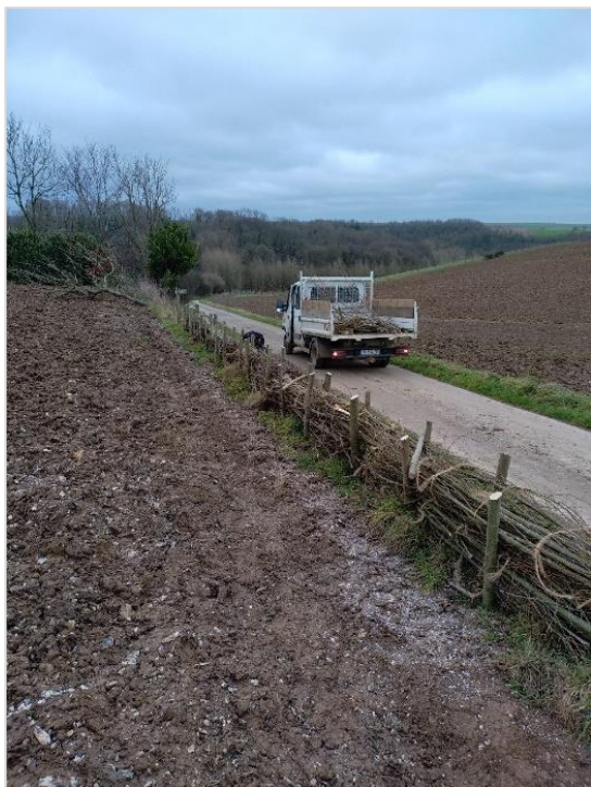
Réalisation d'une fascine à Clenleu
