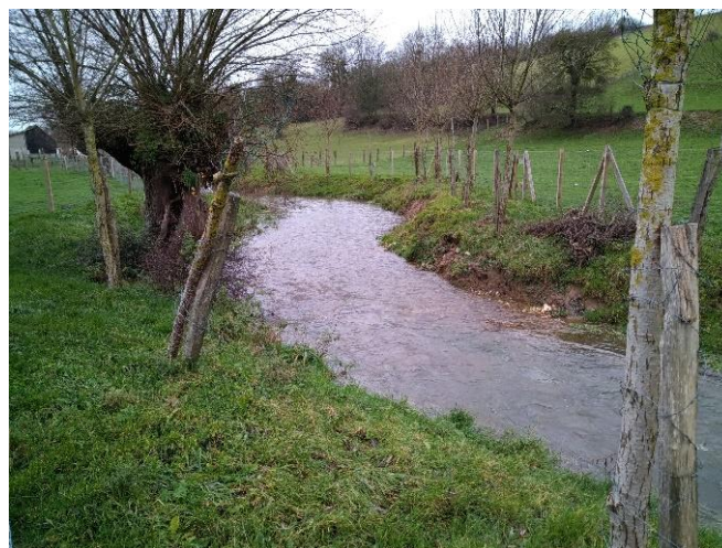
Mise en défend du cours d'eau et arasement seuil
