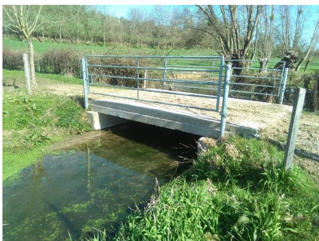
Installation d'une passerelle
