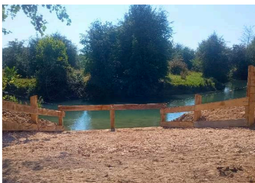
Installation d'une barrière à bovins
