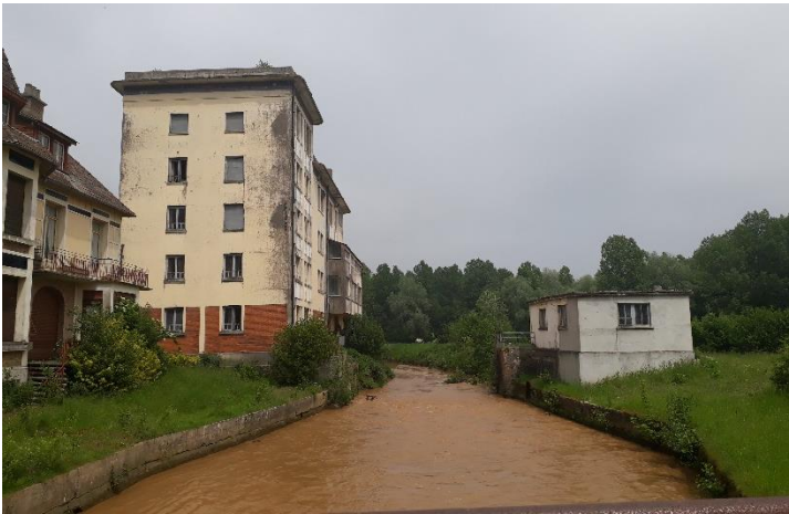
La Ternoise à Rollancourt après un événement pluvieux intense
