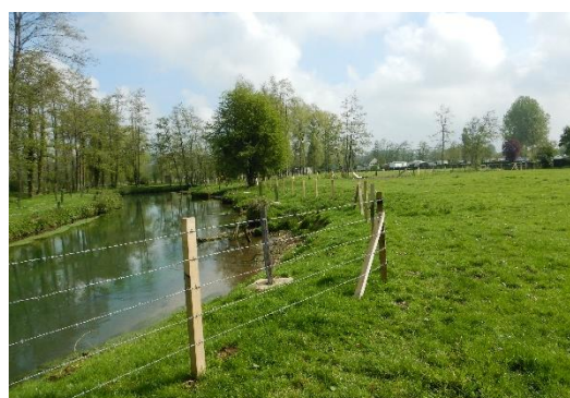
Pose de clôture et plantation
