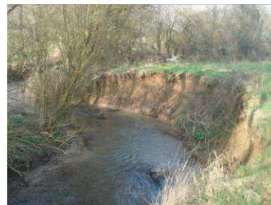
Erosion des berges de la Bimoise (Bi05)
